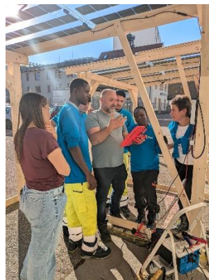
Bau von Agri-Solarmodulen der Azubis des CFPK gemeinsam mit Lehrlingen der SWLB
