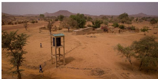
Solar betriebener Tiefbrunnen in Sankondé, Kongoussi
